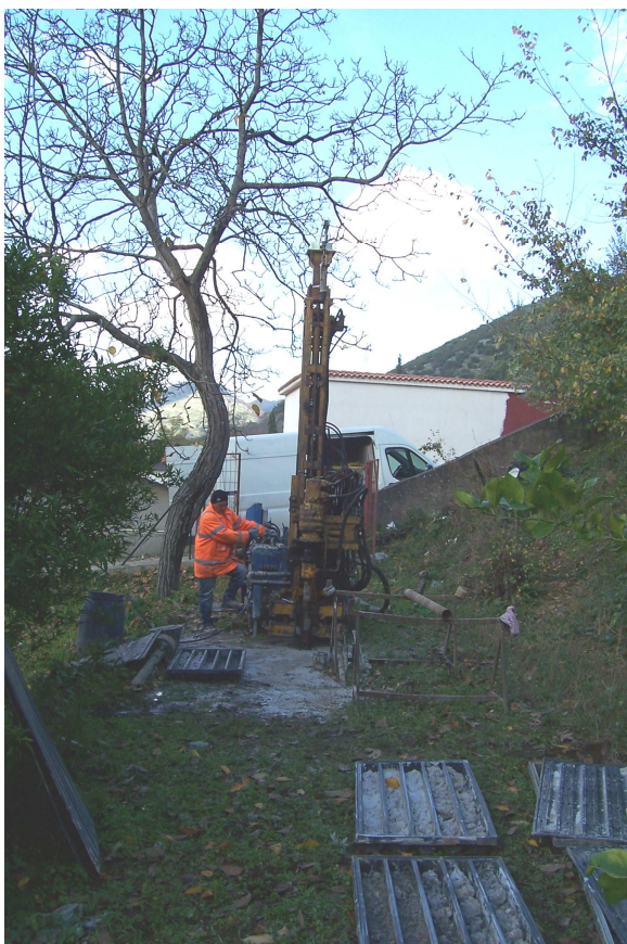
Postazione Sondaggio S1
