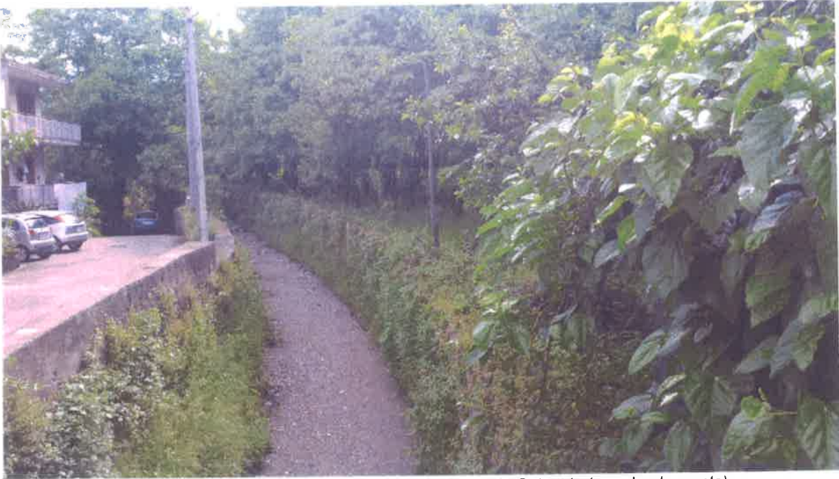
Figura 8: "Rio Secco" – Vista dal Ponte di Via Torrente Catavato (guardando monte)
