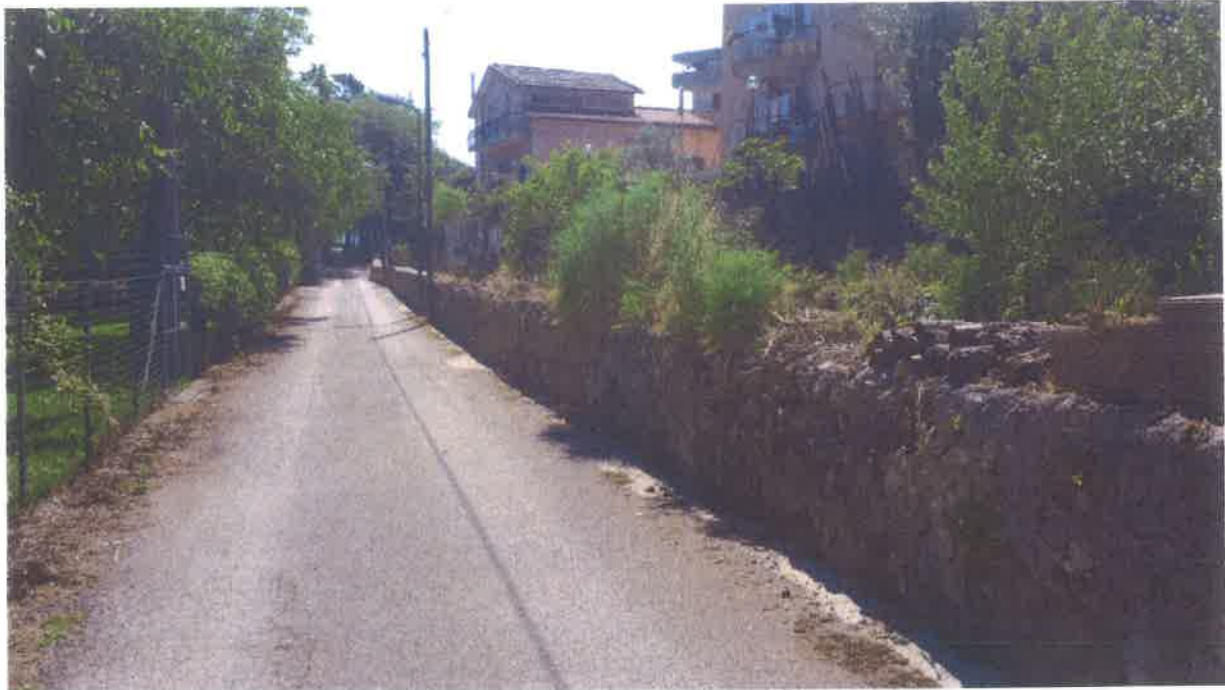
Figura 12: Sponda in destra idraulica del "Rio Secco" (Foto da valle guardando monte)
