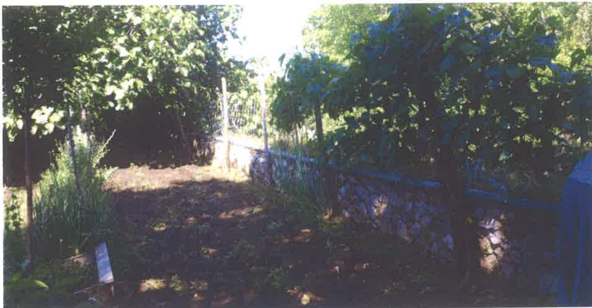
Figura 14: Sponda in sinistra idraulica del "Rio Secco" (vista da monte)
